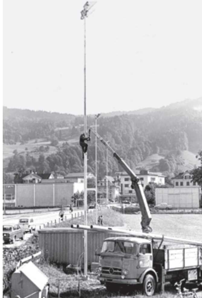
Die Masten werden gestellt. Dieter Peter in luftiger Höhe.
