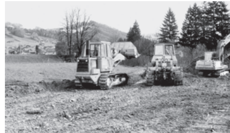
Die schweren Maschinen sind aufgefahren.
